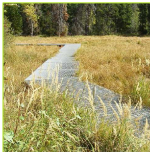
Figure 21 : Passage sur caillebotis galvanisé (Source : Espace Libre)
