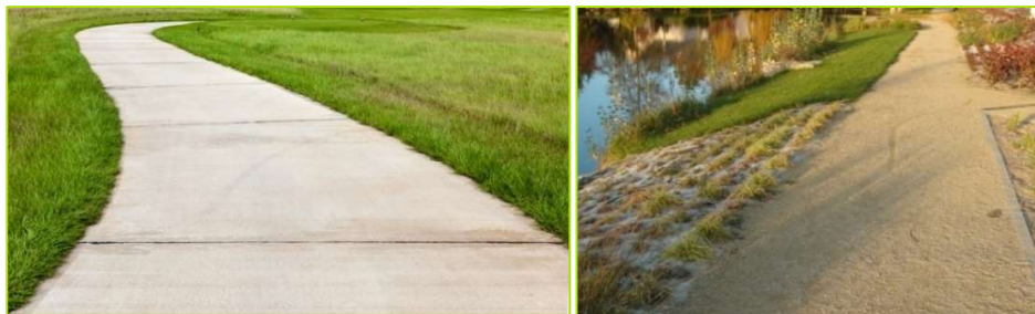
Figure 20 : Chemin en sable stabilisé et chemin en béton (Source : Espace Libre)
